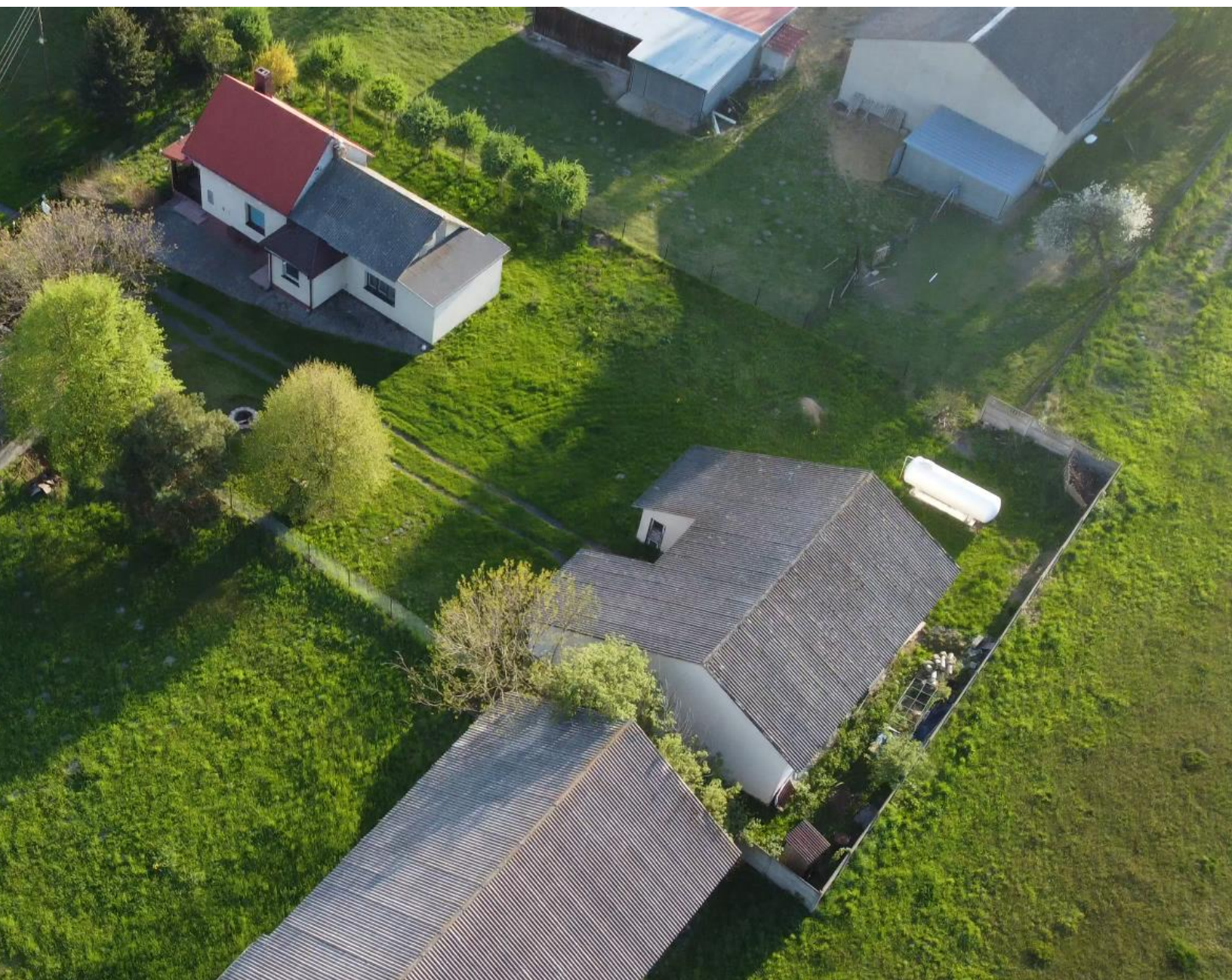
Fot. 1. Wykorzystanie wyrobów azbestowych jako pokrycia dachowe.
